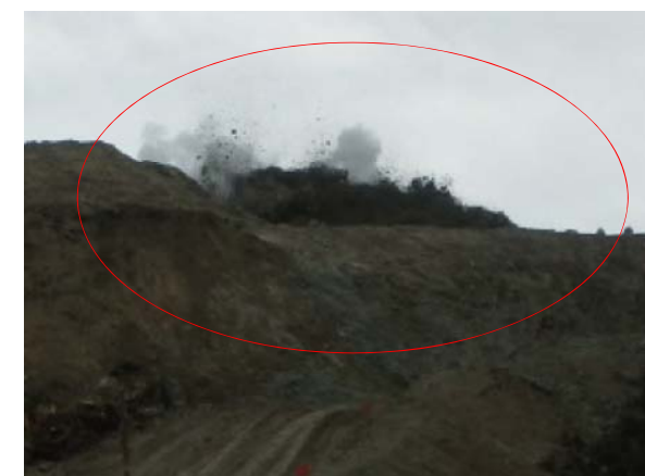
爆破による掘削状況
