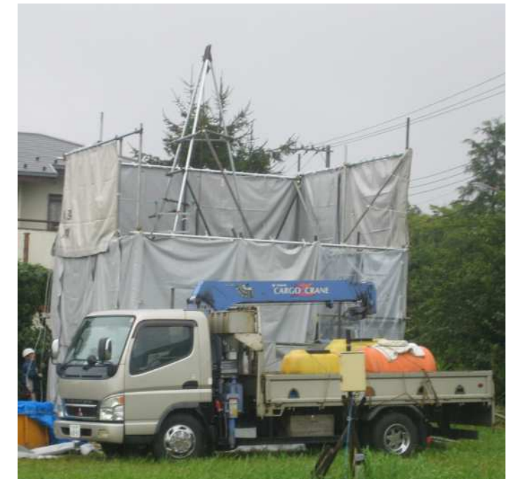
ボーリング調査イメージ
