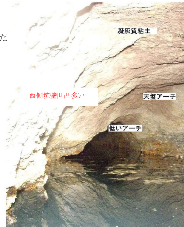
図 1 0° 方向の坑壁と北側の空洞
