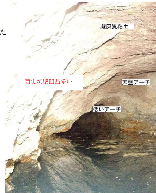
図 1 0° 方向の坑壁と北側の空洞
