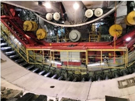
写真2 坑内状況写真(マシン下部)
