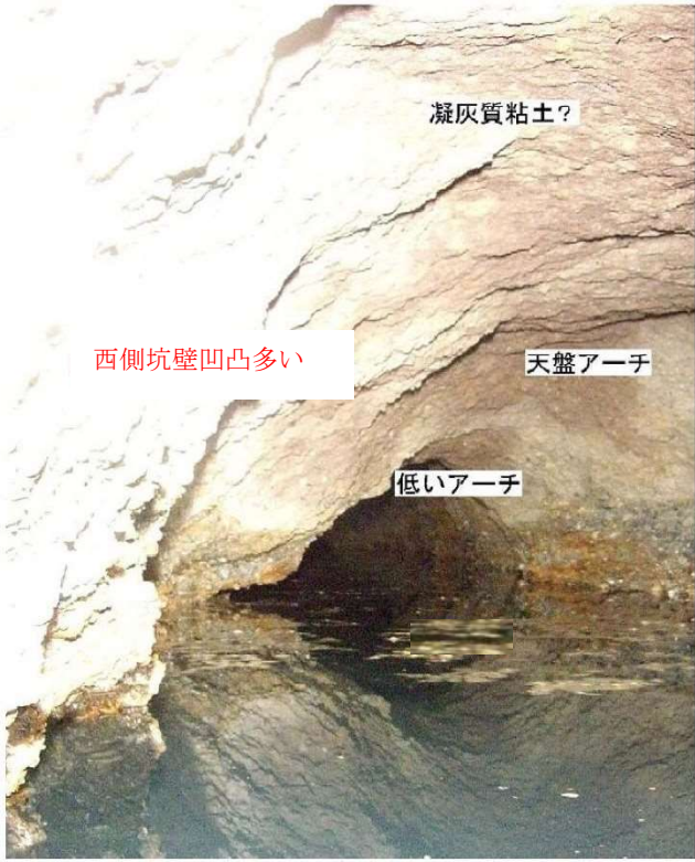
図 3-8 0° 方向の坑壁と北側の空洞
