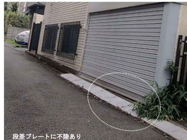
写真 3-2 陥没箇所の事前状況写真（2020 年 7 月 30 日撮影）
