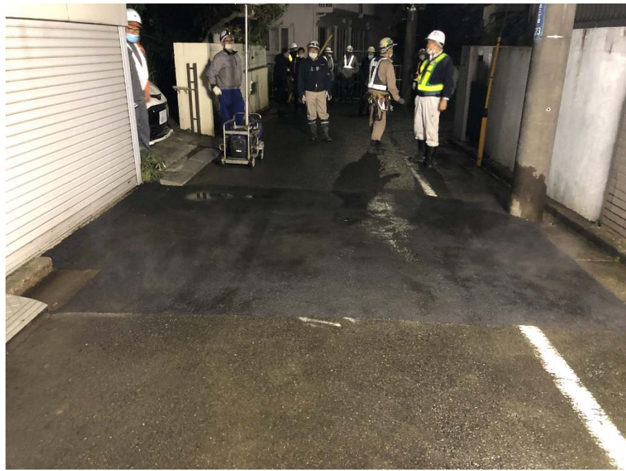
写真6 陥没箇所の応急復旧対応状況(舗装完了)
