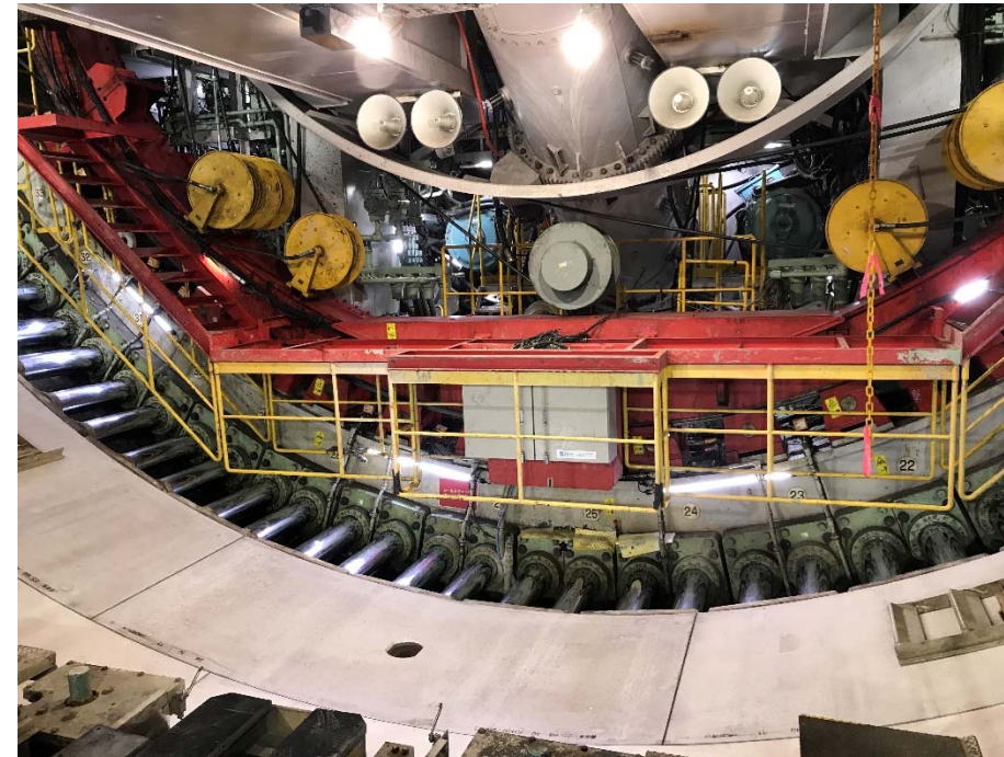
写真2 坑内状況写真(マシン下部)
