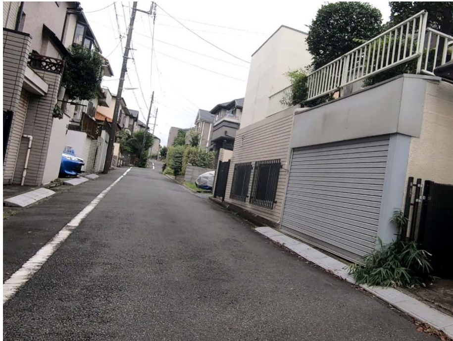
写真1 陥没箇所の事前状況写真(2020年7月30日)
