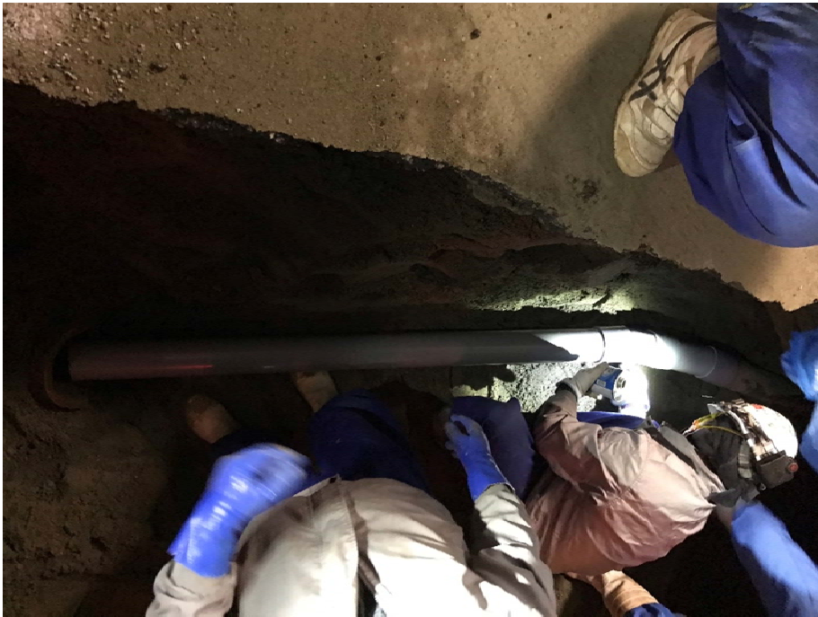
写真4 住宅下水管復旧状況
