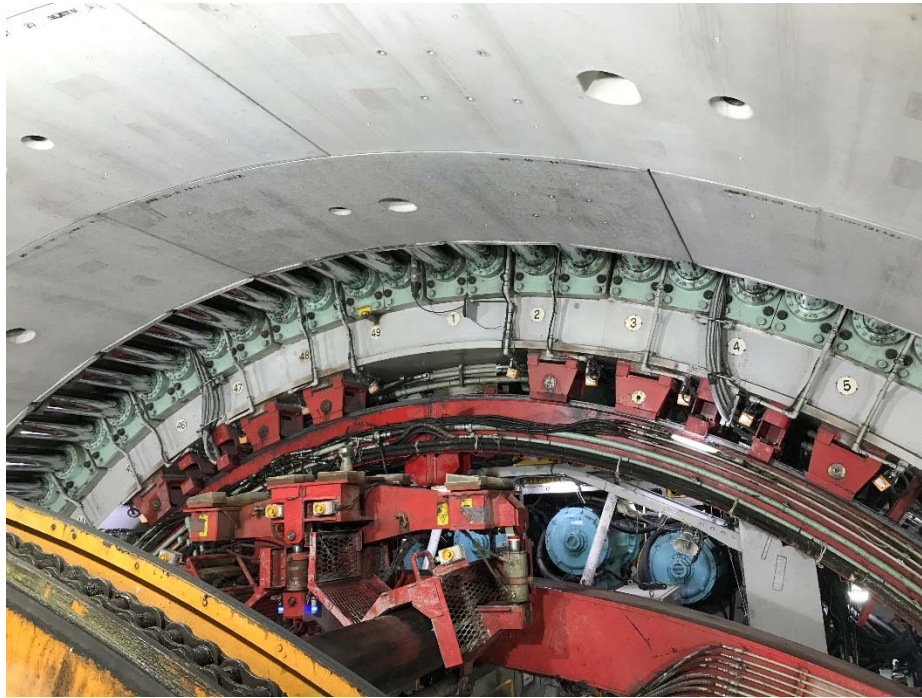
写真1 坑内状況写真(マシン上部)
