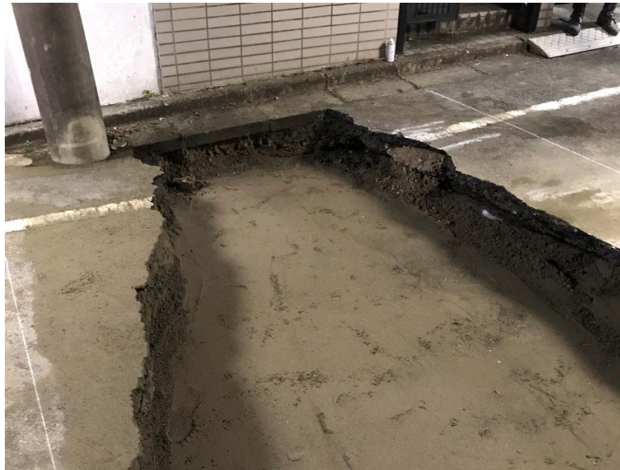
写真5 陥没箇所の応急復旧対応状況(埋戻し完了)
