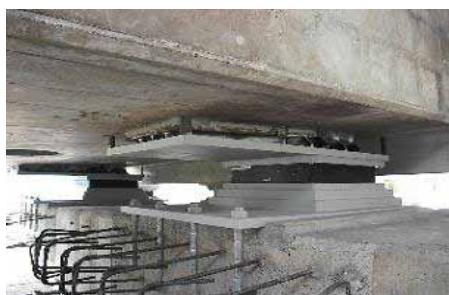
支取替（鋼製 ゴム製）
