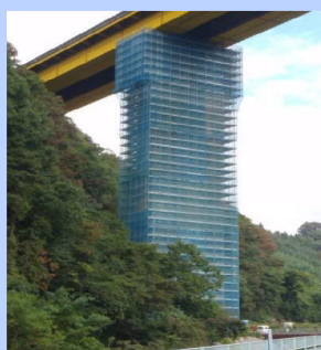
一般構造物用足場を設置した例
