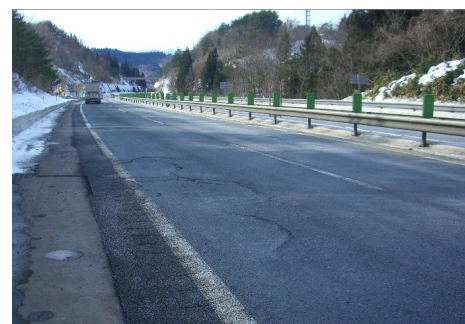
凍上による路面損傷（八戸道）
