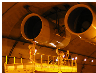
(施設点検) トンネル換気設備の点検
