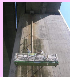
ゴンドラ工法による排水管取替えの状況
