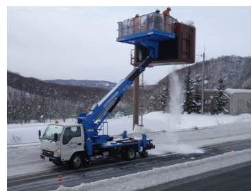
雪氷対策作業状況 (情報板雪落とし)
