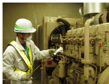
(施設点検) 自家発電設備の点検
