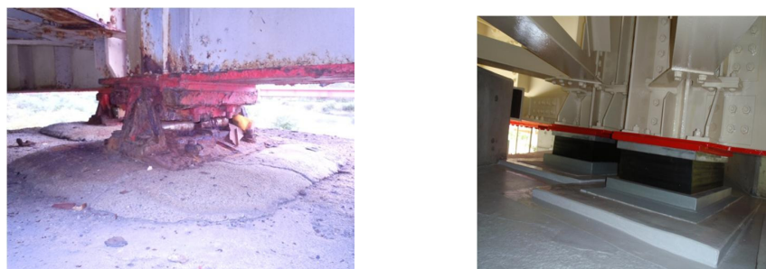
支承の腐食部の補修 東北道 国見IC～白石IC
