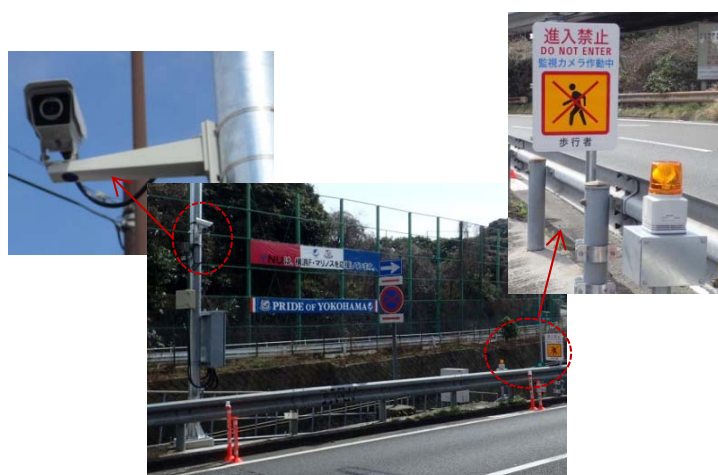
【赤外線カメラによる監視センサ】
