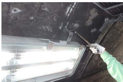
【トンネル照明灯具 緊急点検状況】
