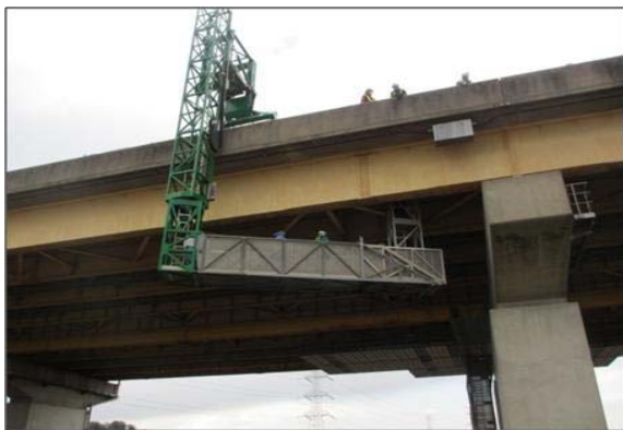
【大型点検車両による点検状況】
