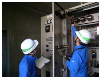
【(施設)受配電設備の点検】
