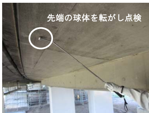
【回転式打音点検器具による点検状況】
