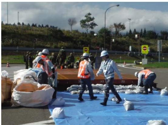
【土のうによる段差修正訓練】
