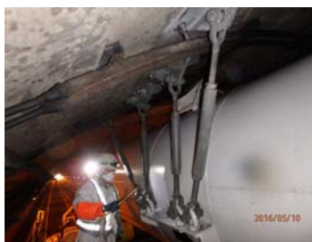
【(施設)トンネル換気設備の点検】
