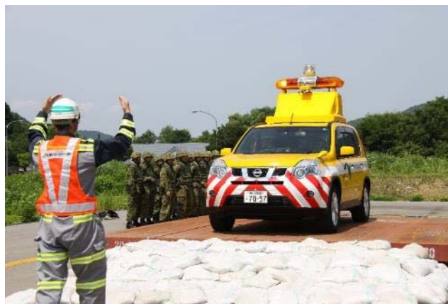
【土のうによる段差修正訓練】
