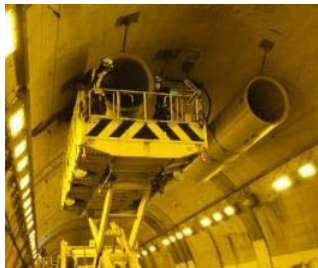
【(施設)トンネル換気設備の点検】
