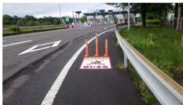
【IC 入口部の路肩に設置した進入禁止ポール、進入禁止看板、通行禁止路面標示】
