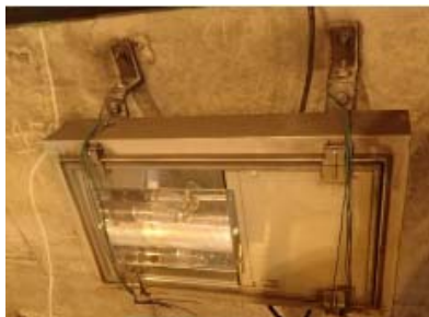
トンネル照明設備劣化部の補修
