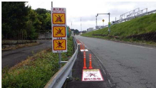
【IC 入口部の路肩に設置した進入禁止ポール、進入禁止看板、通行禁止路面標示】
