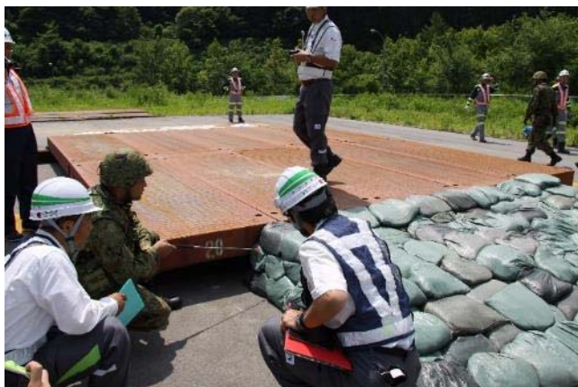
【土のうによる段差修正訓練】
