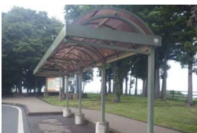
駐車场上屋塗装劣化部の塗装塗替
