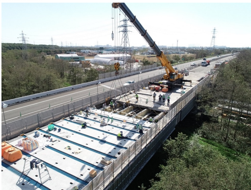
【道央道 勇払川橋床版取替工事状況】
