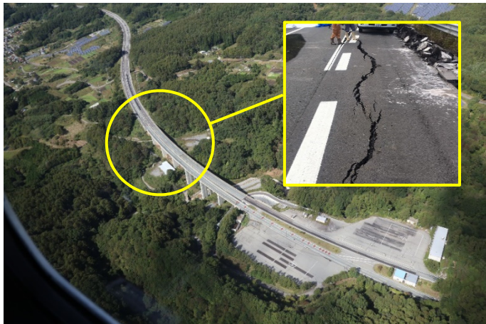
【上信越道（碓井軽井沢 IC～佐久 IC）の盛土の変状】
