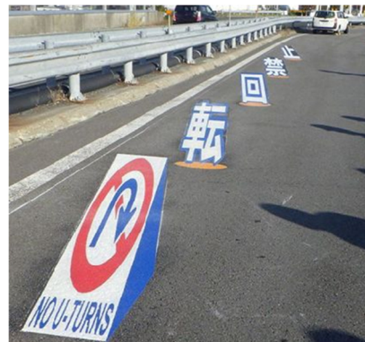
【選定した公募技術の一例（防眩板応用注意喚起・錯視効果を応用した路面標示）】
