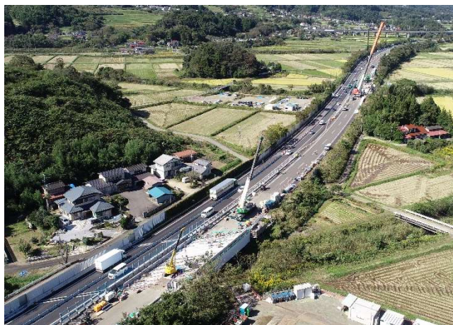
【東北道 塩川橋・齊川橋床版取替工事状況】
