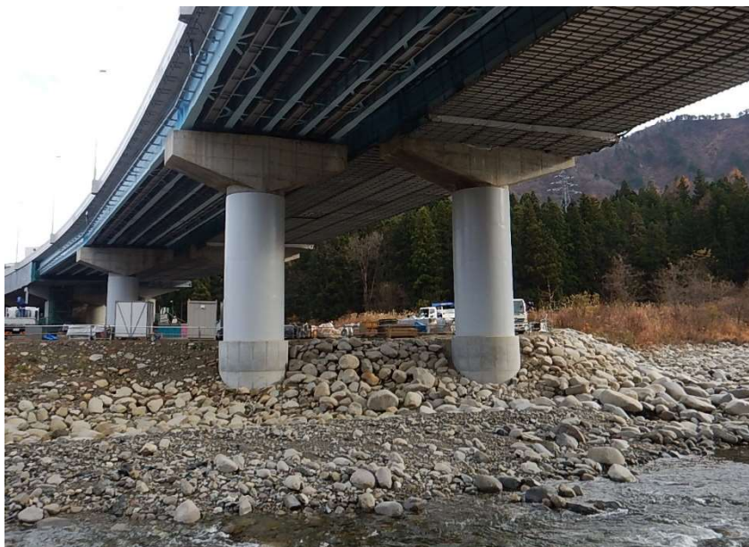
【補強後の橋脚（関越道 松川橋）】
