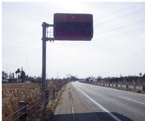
【可変式道路情報板設備の更新
