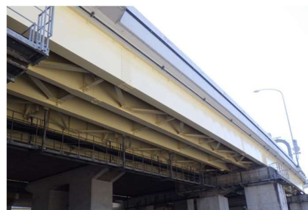
【塗装劣化部の塗替塗装 第三京浜 港北 IC】
