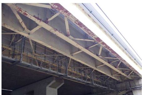
【塗装劣化部の塗替塗装 第三京浜 港北 IC】
