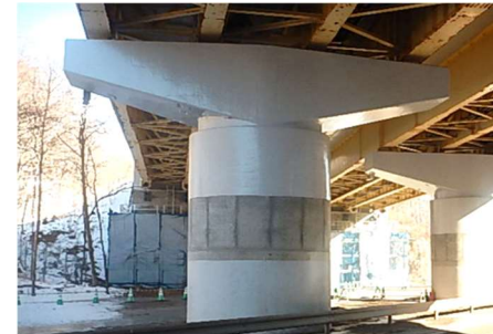
【下部工損傷部の補修 道央道 苫小牧西 IC～苫小牧東 IC】
