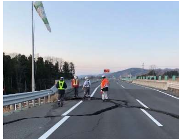
【常磐道 新地 IC～山元 IC 間 舗装の亀裂発生状況】
