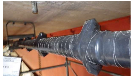
【緊急補修が必要な管路損傷の補修状況（施設）】
