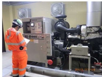
【自家発電設備の点検（施設）】
