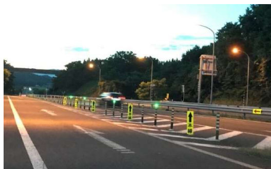
LED発光体付ラバーボールウィングサイン 【秋田道 西仙北スマートIC】
