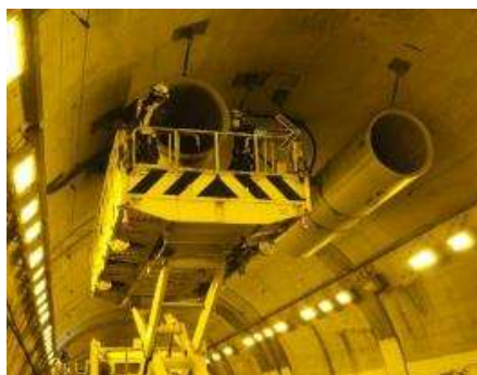
【トンネル換気設備の点検（施設）】
