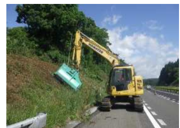
【草刈作業状況】
