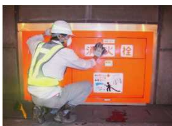
【施設（消火栓）清掃状況】
