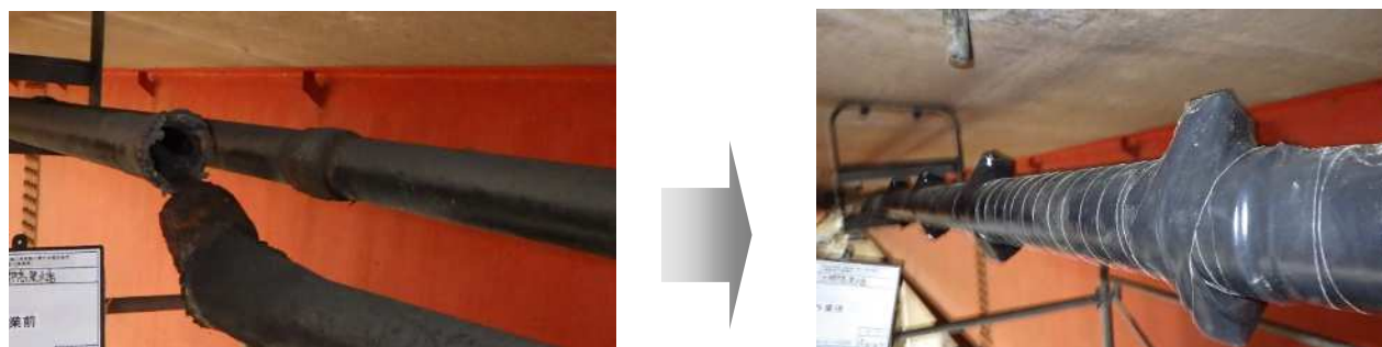
【緊急補修が必要な管路損傷の補修状況（施設）】
