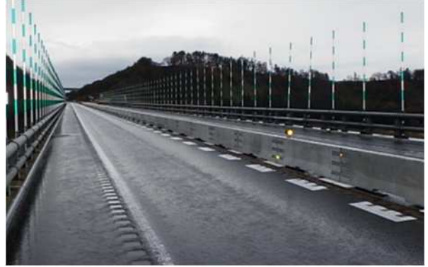
【センターブロック設置状況】 (道央道 森 IC～落部 IC)
