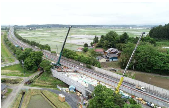
【東北道 地田川橋床版取替工事状況】
