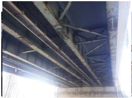
【塗装劣化部の塗替塗装 関越道 藤岡 IC～吉井 IC】
