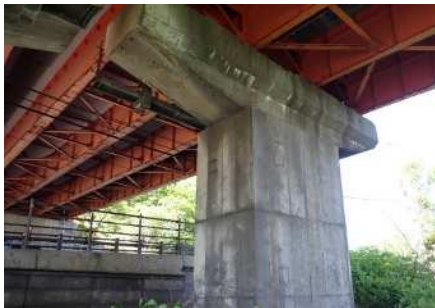
【塗装劣化部の塗替塗装 関越道 藤岡 IC～吉井 IC】
