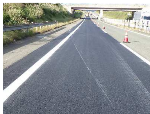
【舗装の補修 関越道 六日町 IC～小出 IC】
