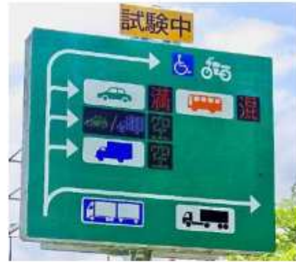
駐車状況のリアルタイム案内標識
