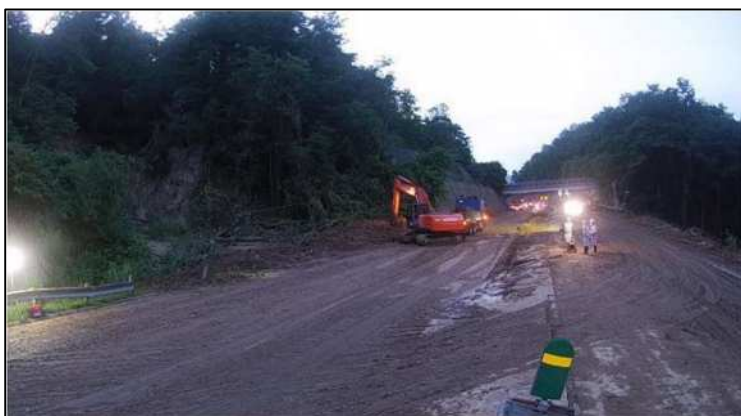
【応急復旧作業の状況】
