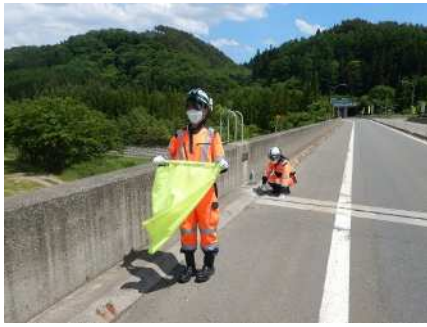
【日常点検（土木）】
