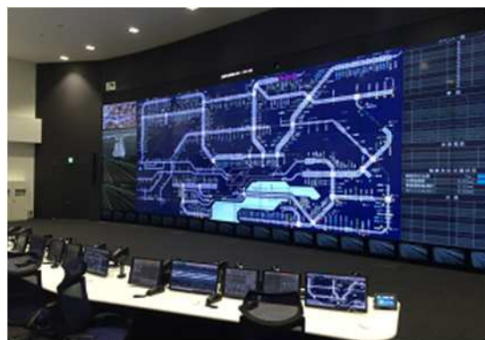
【道路管制センター（交通管制部門）】
