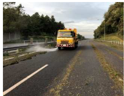
【改良した散水ノズルでの清掃状況】
