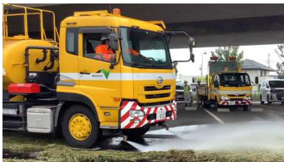
【散水ノズルの改良】
