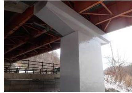
【塗装劣化部の塗替塗装 関越道 藤岡 IC～吉井 IC】
