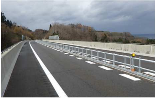
【センターパイプ設置状況】 (道央道 森 IC～落部 IC)
