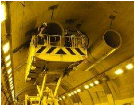
【トンネル換気設備の点検（施設）】
