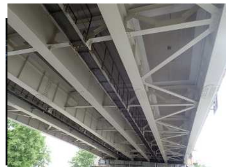
【塗装劣化部の塗替塗装 関越道 藤岡 IC～吉井 IC】
