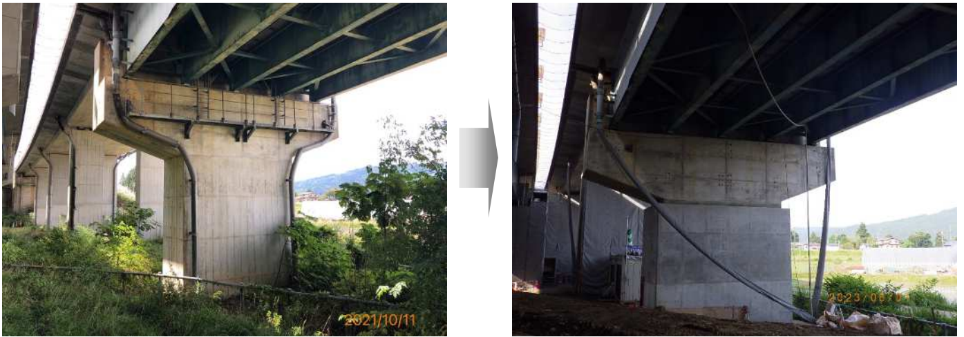
【補強後の橋脚（関越道 三用川橋）】
