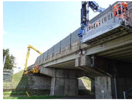
【詳細点検（土木）】
