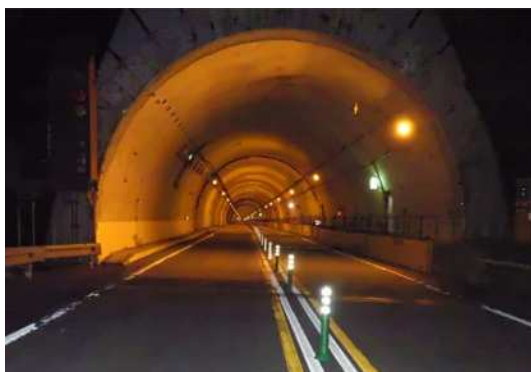
【トンネル照明設備の更新（LED化）
