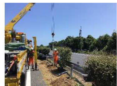
【緊急作業及び事故復旧作業状況】
