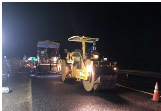
【通行止め区間内での工事状況】
