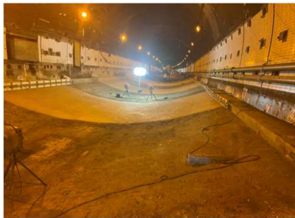
【北陸道 米山トンネルインバート設置工事状況】
