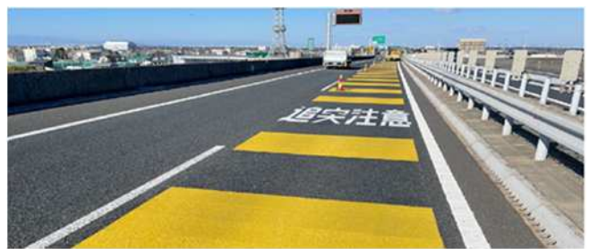
【薄層舗装】 (東京湾アクアライン連絡道 木更津金田 IC～袖ヶ浦 IC)
