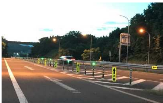
LED発光体付ラバーポールウィングサイン 【秋田道 西仙北スマートIC】
