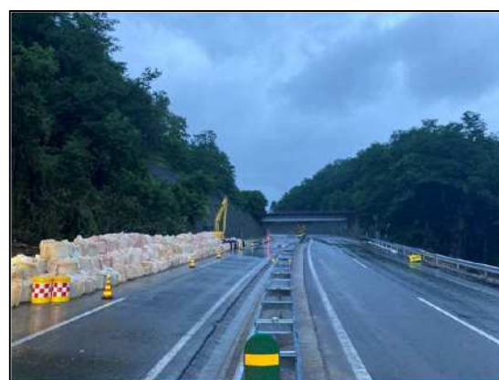
【応急復旧作業完了】
