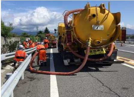
【排水溝清掃状況】
