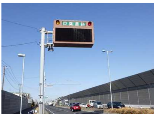
【可変式道路情報板設備の更新
