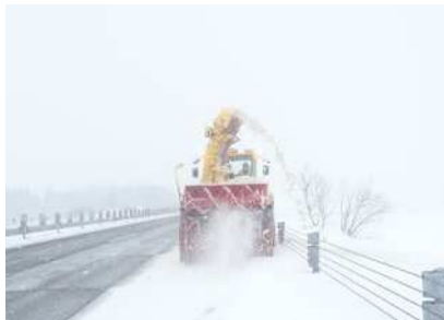
【雪氷対策作業状況(路肩除雪)】
