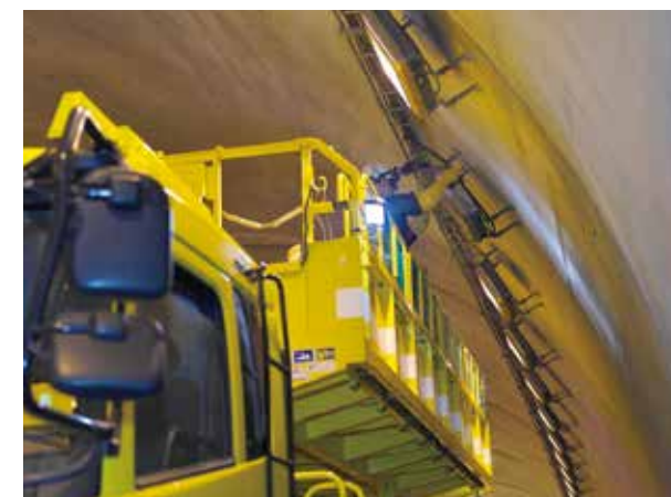
トンネルの照明灯具の清掃
