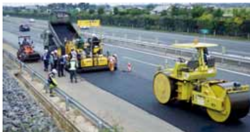
舗装補修作業
