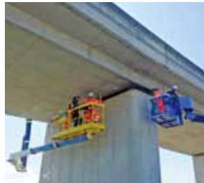
橋梁点検作業車などによる 跨道橋点検
