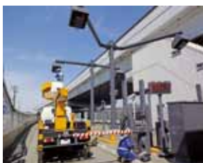
ETC設備点検(アンテナ点検)
