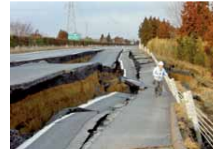
東日本大震災の発生 (大きく被災した常磐道の状況)
