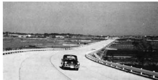
京葉道路 一之江～船橋 開通 翌年日本初の自動車専用道路となる
