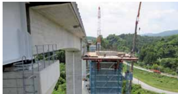
常磐道4車線化工事
