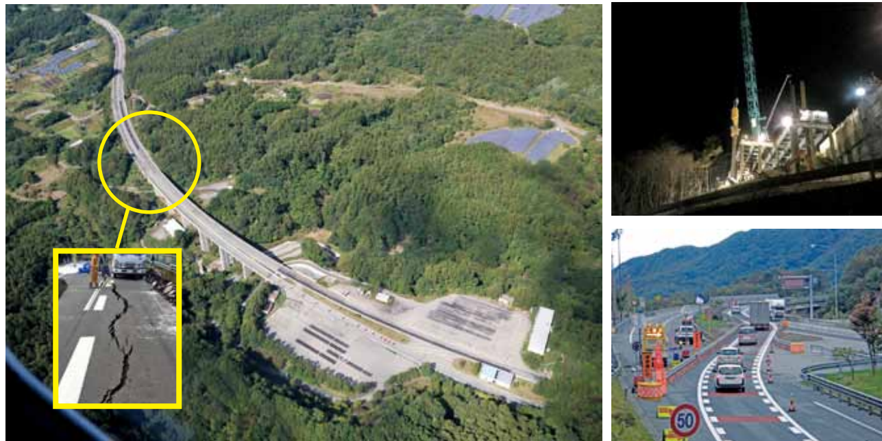
上信越道 碓氷軽井沢IC～佐久ICの盛土の変状 (右上:夜間工事の様子、右下:対面通行の状況)
