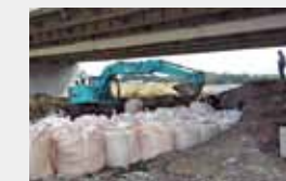
河川決壊箇所の応急復旧支援 (壬生町内)
