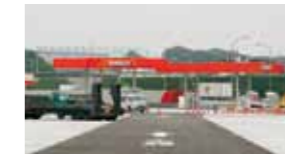
燃料補給に備えた石油タンク容量の増強
