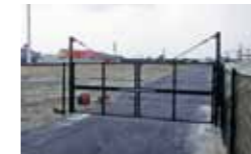
緊急開口部 緊急車両の出入り口確保
