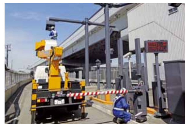
ETC設備点検 (アンテナ点検)
