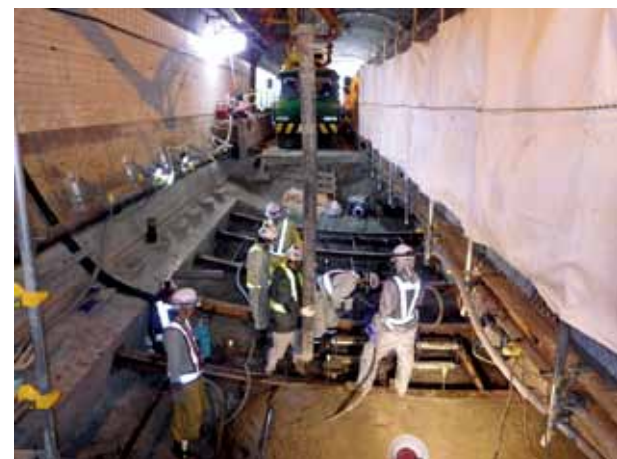
トンネルのインバート設置
