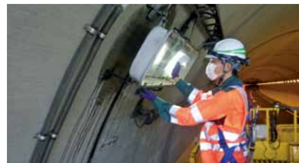
トンネル照明灯具の清掃
