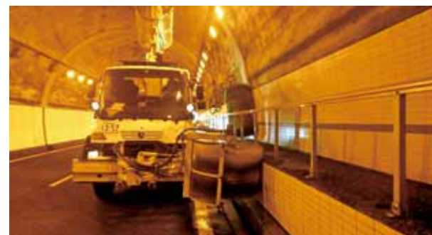
トンネル壁面の清掃
