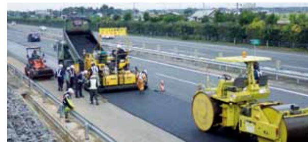
舗装補修作業
