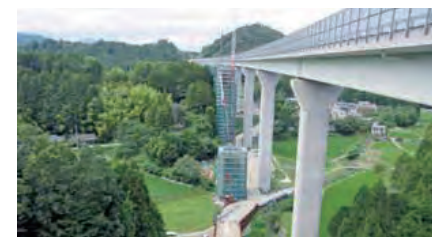
鋼管・コンクリート複合橋脚の採用(折木川橋)
