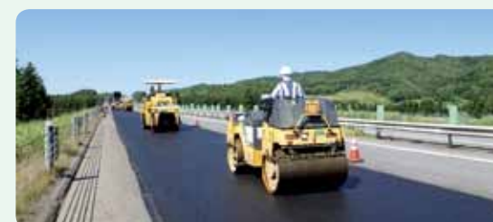
舗装補修作業
