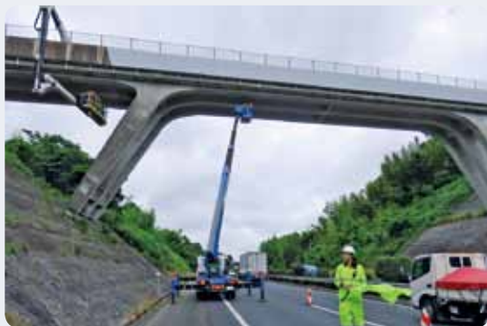
橋梁点検作業車によるオーバーブリッジ点検
