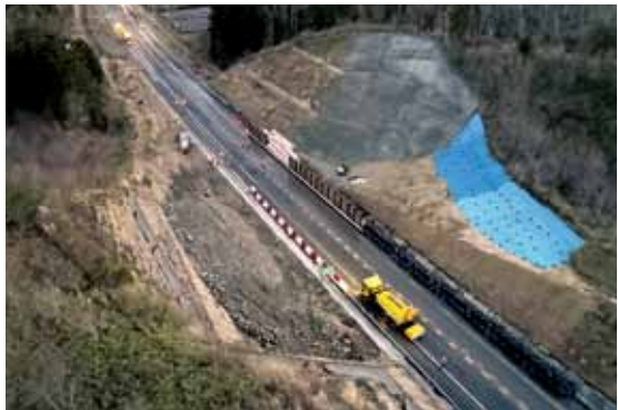
常磐道 切土のり面崩落箇所 応急復旧後
