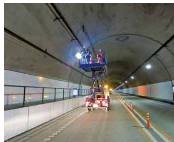
トンネル照明設備の点検
