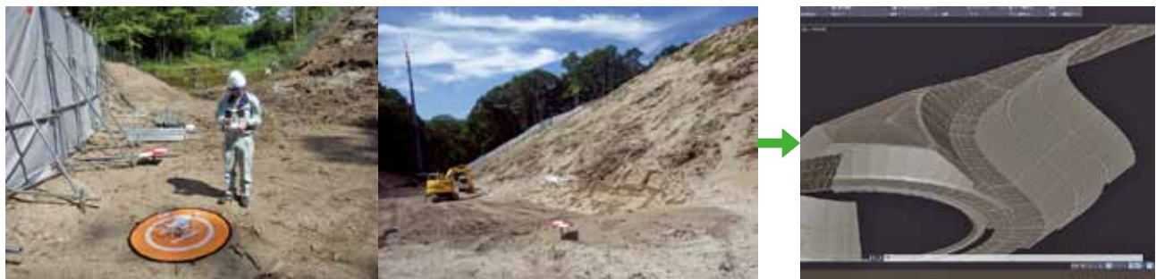
ドローンを、建設現場に飛行させ、地形データを収集
