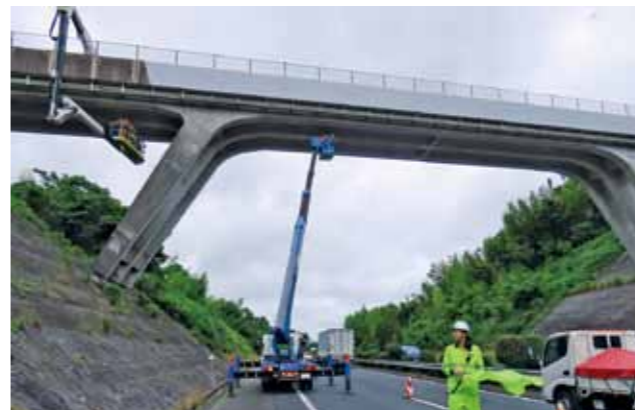
橋梁点検作業車によるオーバーブリッジ点検
