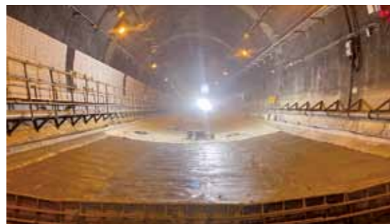
トンネルのインパート設置（施工後）
