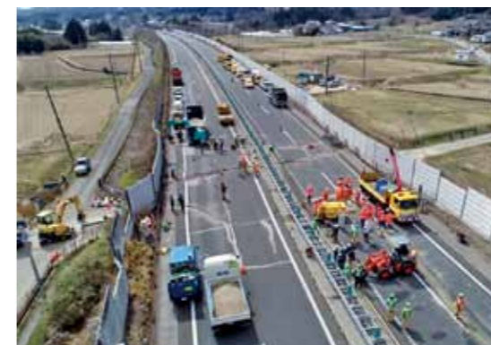
応急復旧作業の様子
