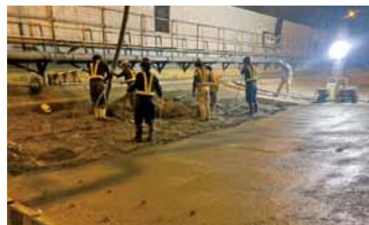
トンネルのインパート設置（施工中）
