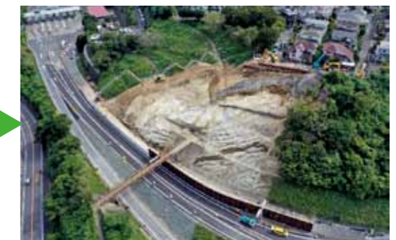
横浜横須賀道路 逗子IC 大雨に起因する切土のり面崩壊後(左)と利用再開後(右)の様子
