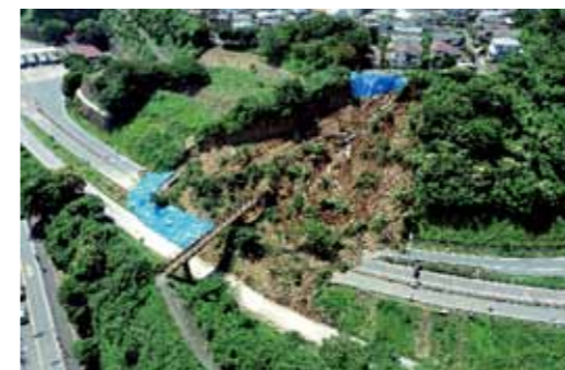
横浜横須賀道路 逗子IC 大雨に起因する切土のり面崩壊後(左)と利用再開後(右)の様子
