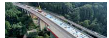
床版取替工事の実例
