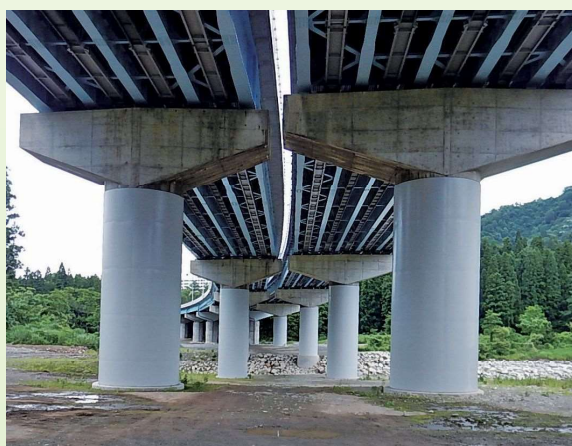
橋脚補強(巻き立て)工事の例
