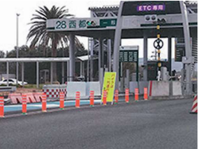
締切対策(料金所プラザ部)
