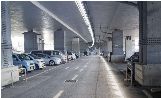
高架下駐車場（東北道 岩槻IC付近）
