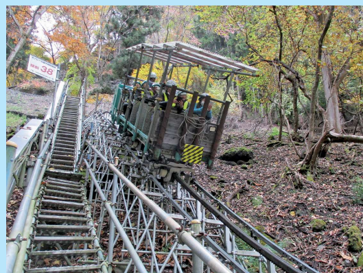
工事用モノレールへの乗車
