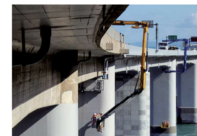
橋りょう点検
