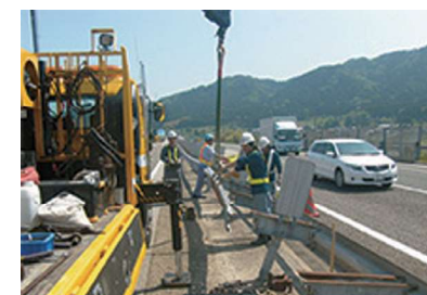
事故復旧工事
