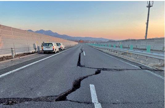
2022年3月16日 福島県沖地震 被災直後の状況 （東北道 国見IC～白石IC間）
