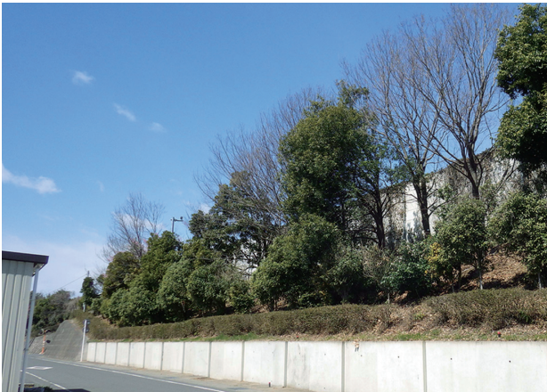
建設から約20年経過したのり面の植栽状況
