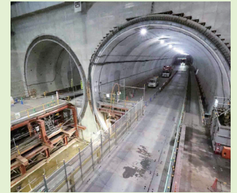
横浜環状南線(圏央道) 金利谷JCT~戸塚IC間 桂台トンネル
