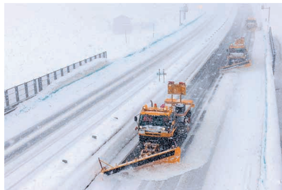
除雪作業の様子
