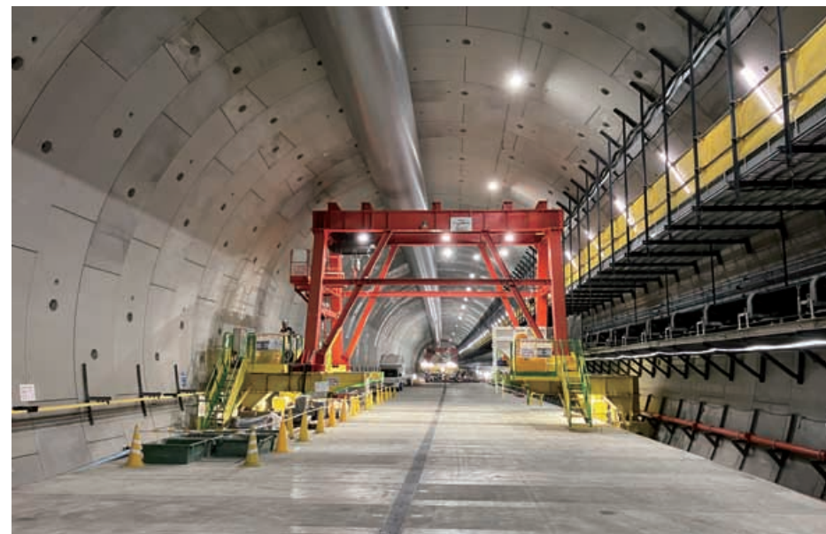
南行トンネル（大泉JCT部）
