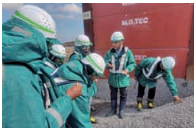
舗装工事現場における舗装材料の品質確認 (Cube社訪日時)
