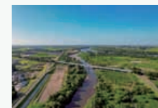
【表紙裏】 (撮影場所) 磐越道 早出川橋
