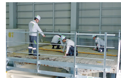
NEXCO東日本総合技術センター内 橋りょう点検疑似体験の様子
