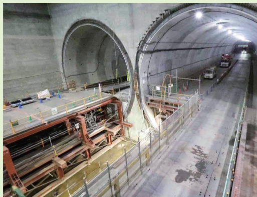
横浜環状南線（圏央道）釜利谷JCT～戸塚IC間 桂台トンネル
