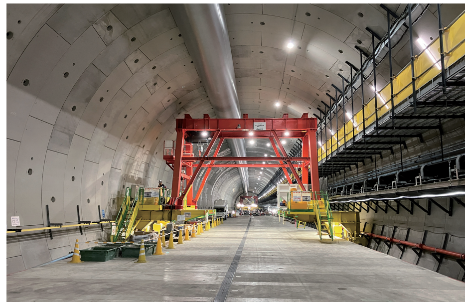
南行トンネル（大泉JCT部）
