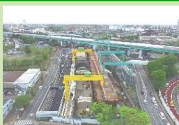
東京外環自動車道(大泉JCT)建設現場
