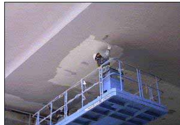
コンクリート剥落対策工事
