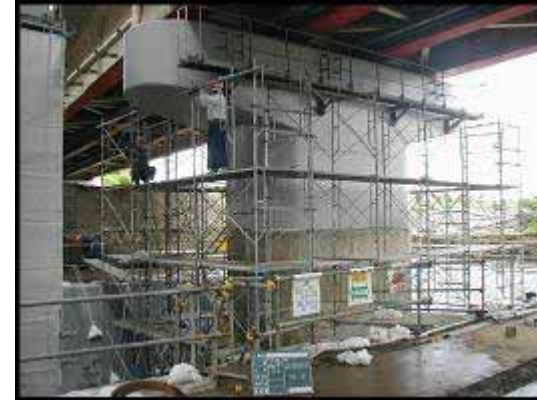
橋梁の耐震補強工事
