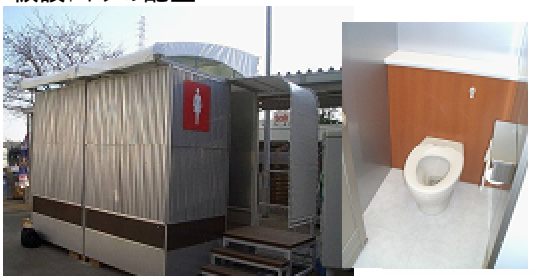
仮設トイレの配置
