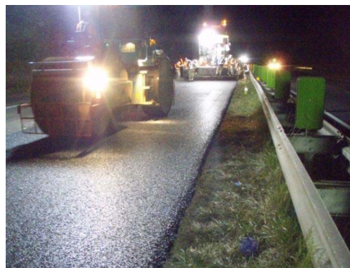
夜間工事の状況(東北道 若柳金成～一関)
