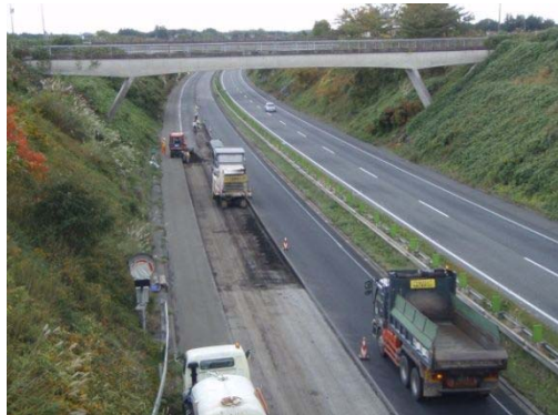
舗装本復旧工事の状況(東北道 築館～若柳金成)
