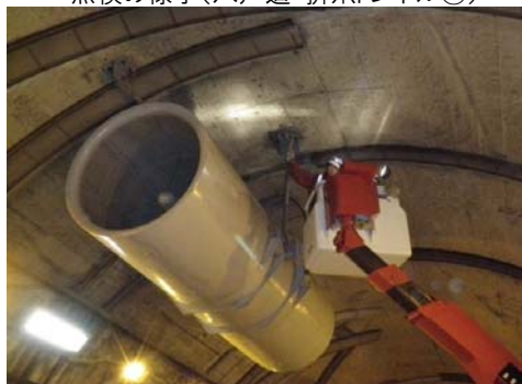
点検の様子(八戸道 折爪トンネル④)
