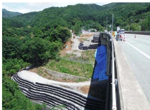
応急復旧工事状況
