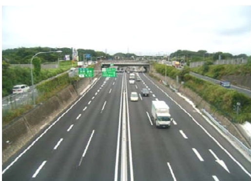
付加車線の運用状況
