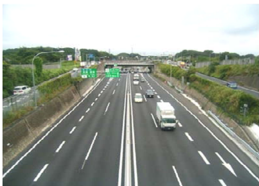
付加車線の運用状況
