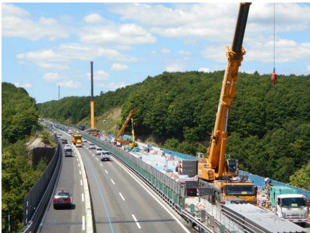
道央道 しまつがわ 島松川橋床版取替工事
