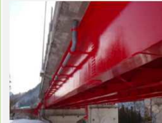
鋼桁塗装（塗替塗装）
