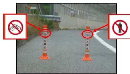
(高速道路出入口部の路肩にポール設置)
