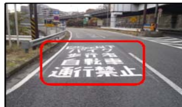
(高速道路入口部に通行禁止の路面標示)
