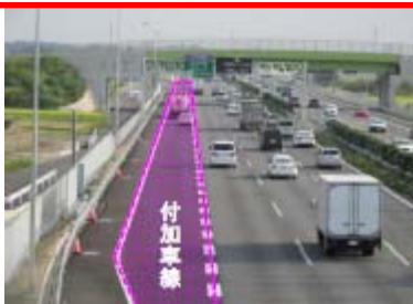
関越道高坂SA付近の付加車線
