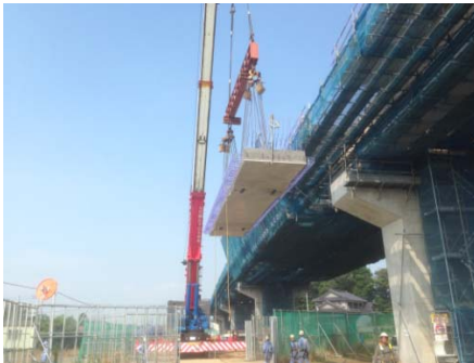
◀プレキャストPC(プレストレスト・コンクリート)床板架設の工事現場
