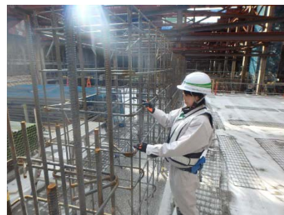
▲鉄筋の配筋検査の様子
