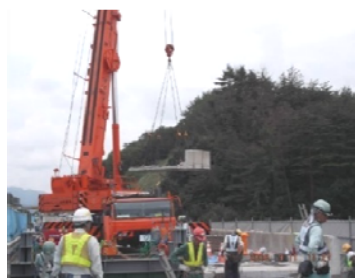
老朽化した既設の床版を撤去する作業
