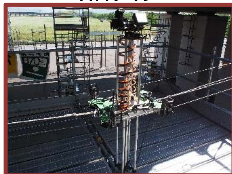
桁下から見えにくい箇所 の点検に威力を発揮
