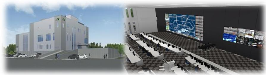
▲新道路管制センター全景
