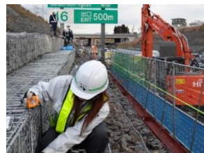
▲切土のり面補強工事の ふとんかご工の高さ検測をする山崎氏
