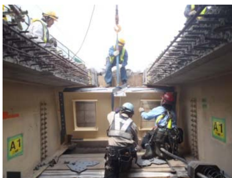
▲橋梁部の中央分離帯を連結させるための 主桁の増設作業
