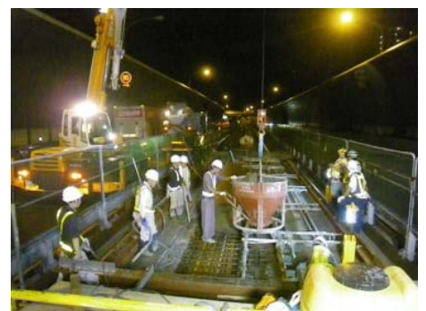
▲橋梁部の中央分離帯を連結させる 床版コンクリートの打設作業
