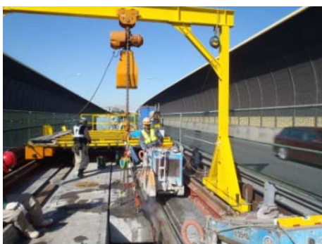
▲上下線が分離されている橋梁部 中央分離帯の床版切断・撤去作業
